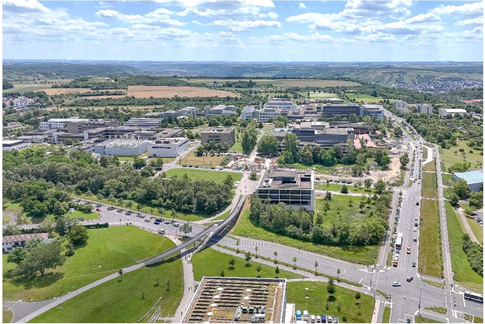
Abb.24: Luftbild, Standort 1a/1b/1c und 2a/2b, Aufnahme von Norden (Staatl. Bauamt Würzburg, 2024)
