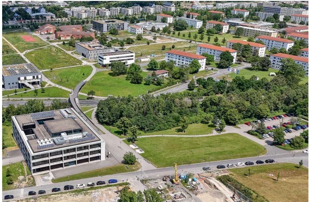
Abb.23: Luftbild, Standort 2a/2b und Standort 1a/1b/1c, Aufnahme von Süd-West (Staatl. Bauamt Würzburg, 2024)
