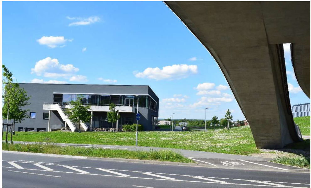
Abb.14: Standort 1a, Perspektive von der Straße „Am Galgenberg“ (Staatl. Bauamt Würzburg, 2024)
